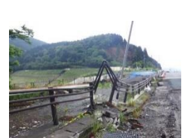
ガードパイプ (西原村)
