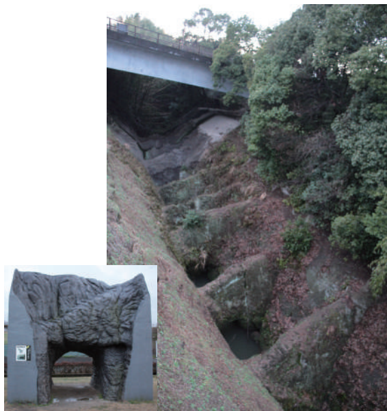
▲掘削時に一部を壁のように残し、その下辺をくりぬいてトンネル状にした「鼻ぐり」は、工事の簡略化と水流により川底に土砂がたまらないようにする仕組み
