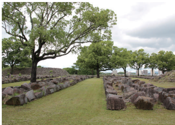
▲復旧にはなるべく元の材料を使う必要があるため、石垣の石も一つずつ番号をつけて管理しながらの復旧工事となる。このためとても時間がかかる
