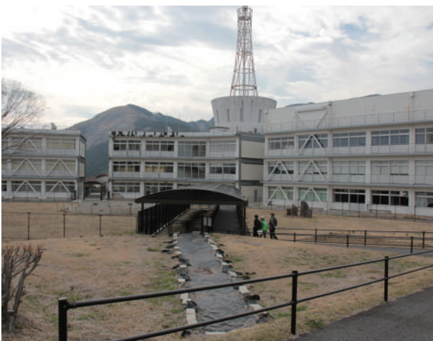
▲キャンパスを縦断する地表地震断層などがみられる旧東海大学阿蘇キャンパス
